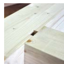
Jonction sécurisée avec goupille de verrouillage
