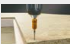
Pose de panneaux OSB
